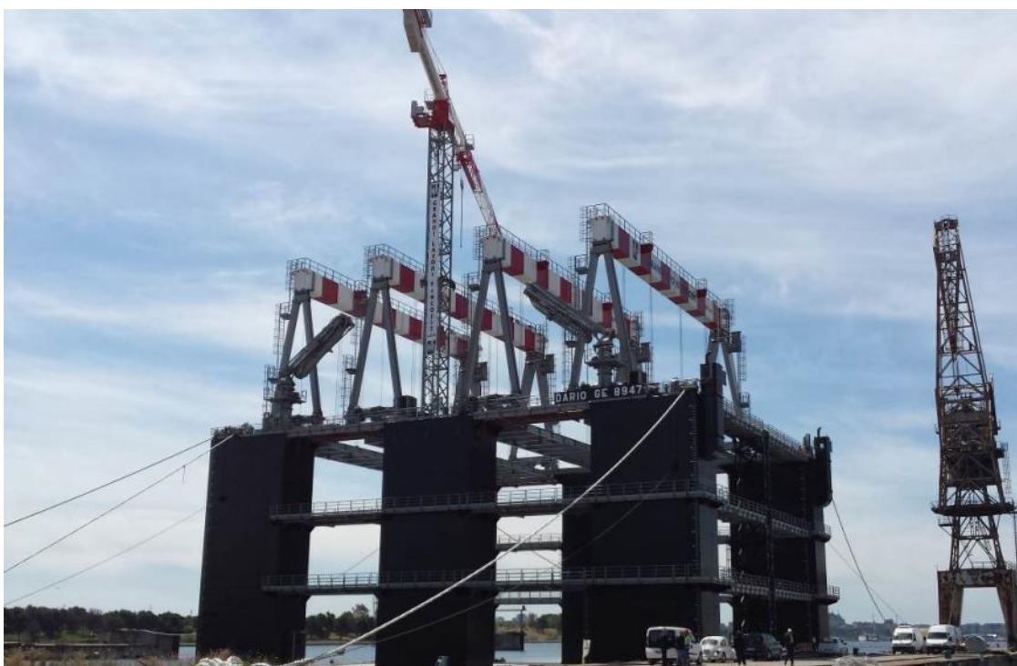
Bc DARIO RI 88728 Grandi Lavori FincositSpA – presso Cantiere NIGROSrl Taranto 2011-2014 Progettazione e Direzione Lavori Bacino galleggiante per la costruzione di cassoni cellulari in CLS
