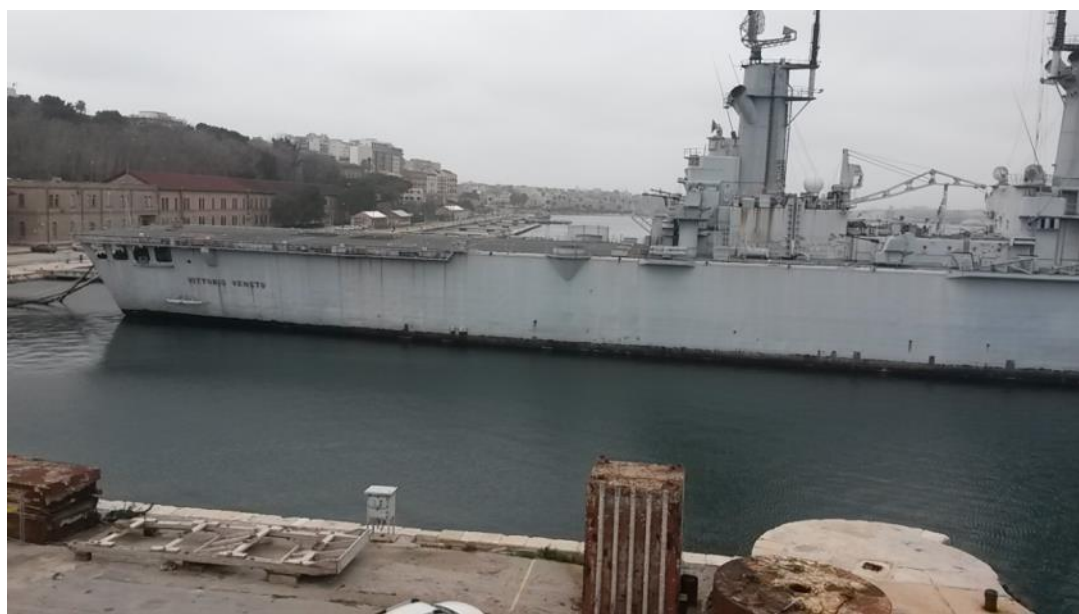
Galleggiante GT01 (ex Nave Vittorio Veneto)- MMI – Attività di mappatura e redazione del MIMPe verifica integrità strutturale
