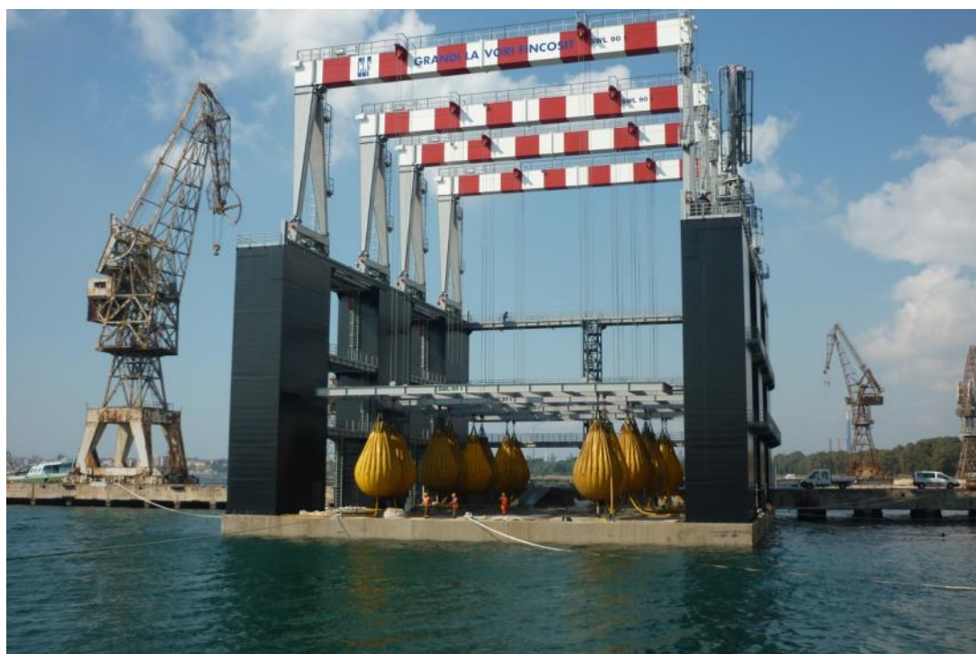
Bc DARIO RI 88728 Grandi Lavori FincositSpA – presso Cantiere NIGROSrl Taranto 2011-2014 Fase Collaudo Carriponte su Bacino galleggiante per la costruzione di cassoni cellulari in CLS
